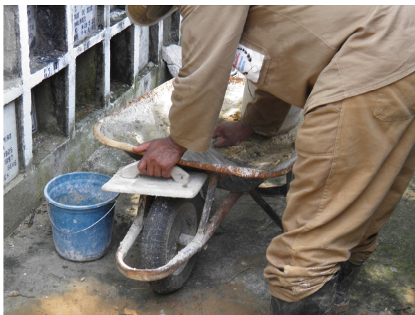
Figura 13 - Preparação da mistura areia e cal.
