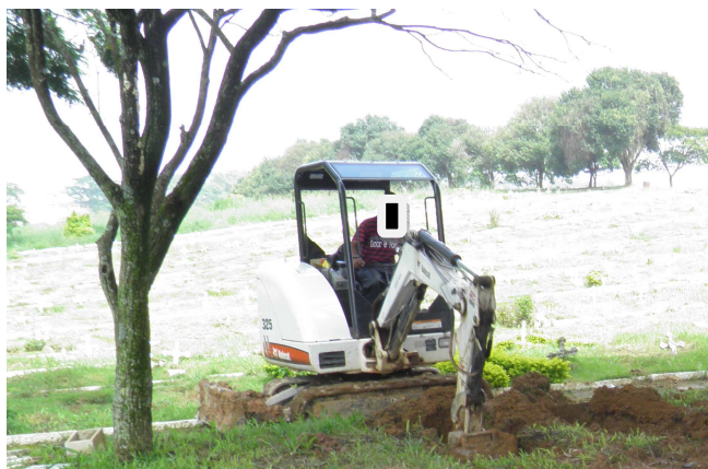
Figura 2 - Mini Escavadeira BobCat 325 abrindo covas.
